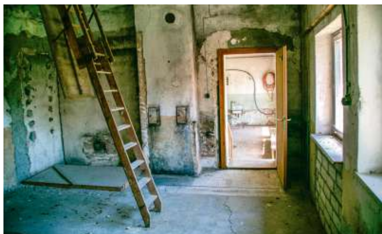
Die Umbauarbeiten darin befinden sich derzeit in vollem Gange.
